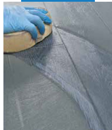
Čistenie a finálne dočistenie škár na podlahách s použitím šponge
