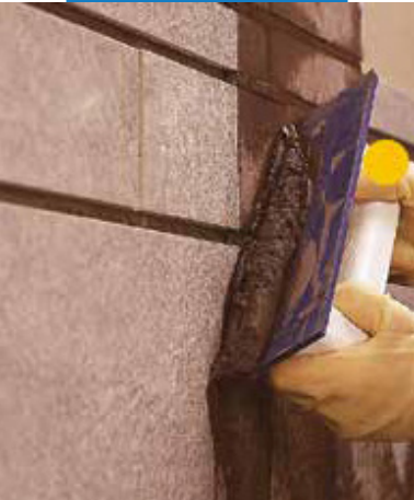
Nanášanie Ultracolor Plus na dlažbu so špeciálnym gumovým podlahárskym náradím
