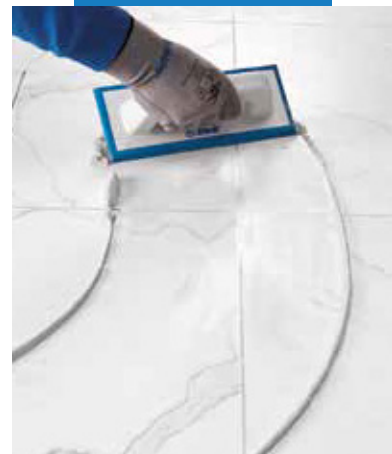
Nanášanie Ultracolor Plus na podlahu s gumovou stierkou
