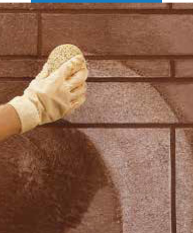
Čistenie a finálne dočistenie škár na stenách s použitím špongie
