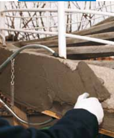
Aplikácia Mapegrout 430 murárskou lyžicou
