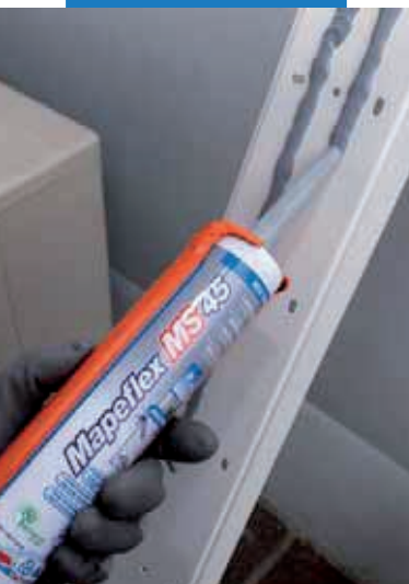
Lepenie plastového profilu v exteriéri
