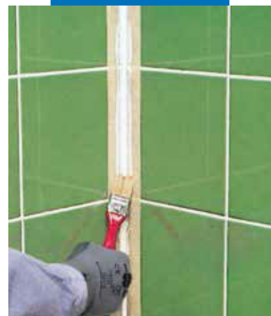
Vyhľadovanie povrchu škáry saponátovým roztokom a malým štetcom
