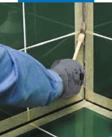
Nanášanie penetračného náteru Primer FD
