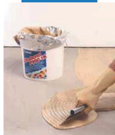
Nanesenie lepidla na podklad
