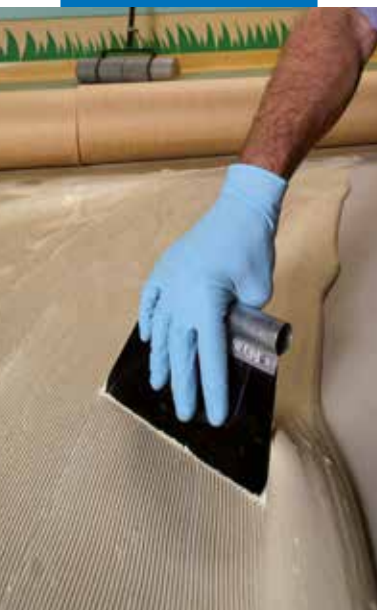
Nanášení lepidla Ultrabond Eco 520
