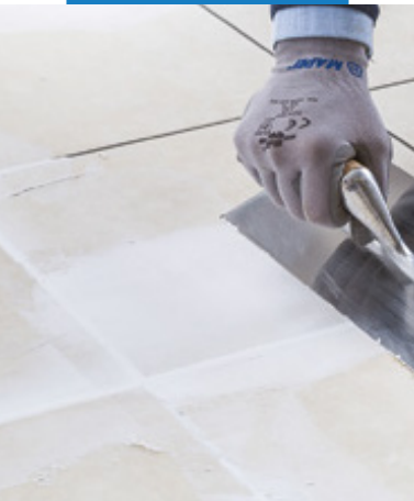
Vyrovnanie a výplň škár v existujúcej keramickej dlažbe s použitím Planiprep 4 LVT
