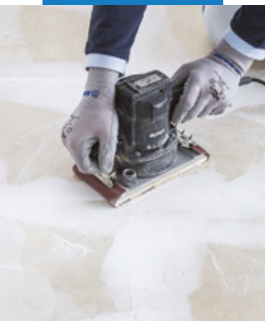
Prebrúsenie vyrovnaného povrchu Planiprep 4 LVT
