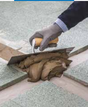
Vyplnění průchodů pro kabeláž s použitím výrobku Planipatch Fast Track
