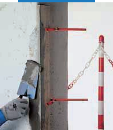
Oprava zvislej hrany na stene maltou Nivorapid
