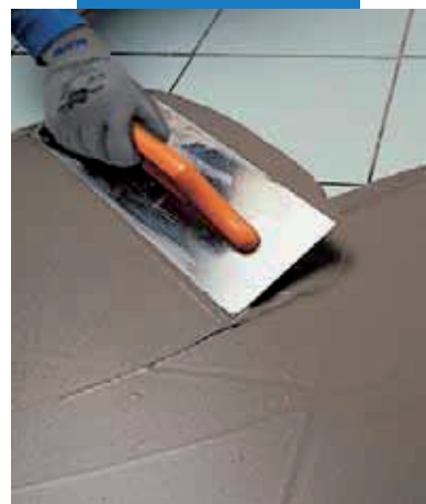
Vyrovnanie existujúcej keramickej dlažby maltou Nivorapid
