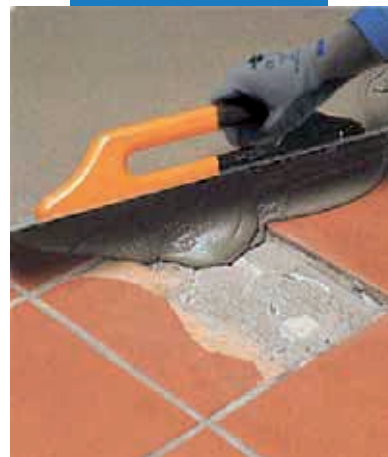
Otvory v keramickej dlažbe vyplnené maltou Nivorapid
