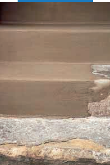
Schody pred a po aplikácii malty Nivorapid
