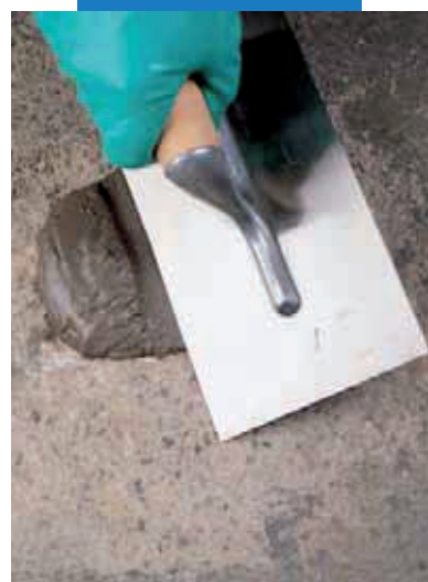
Oprava vodorovného povrchu maltou Nivorapid
