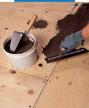
Nivorapid + Latex Plus použitý pri výplni škár v drevenej podlahe
