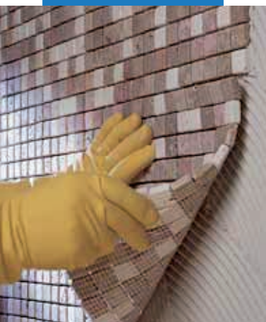
Inštalácia mramorovej mozaiky na stenu
