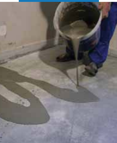
Planolit 315 aplikovaný na podklad ošetrený penetračným náterom Primer G
