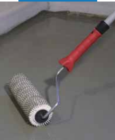
Valček s ostňami použitý na odvzdušnenie nanesej vrstvy Planolit 315
