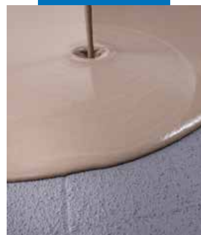
Aplikácia samonivelizačnej malty Ultraplan na vyschnutý Eco Prim Grip na starej podlahe
