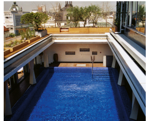
Obklad bazéna s PCI Collastic®.
