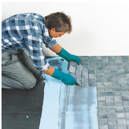
Obklad / dlažbu položiť do lepiaceho lôžka a vyrovnať.
