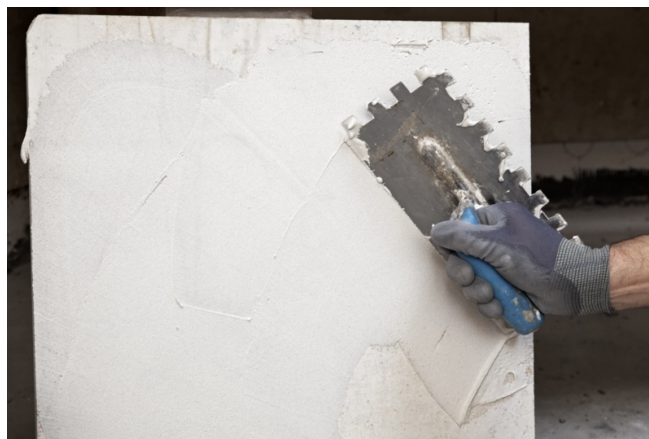
Pri bezdutinovej pokládke je potrebné naniesť maltu aj na rubovú stranu dlažby.
