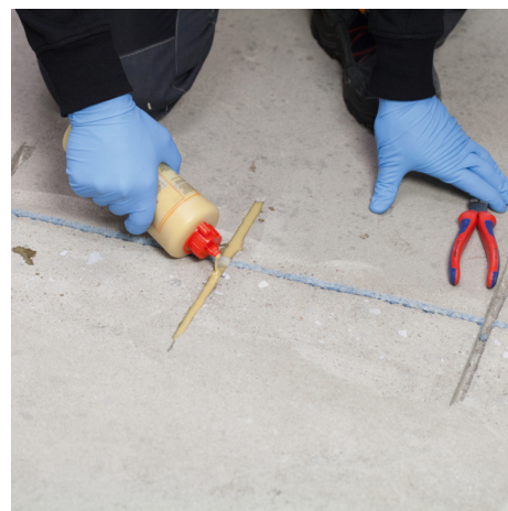
Drážku alebo škáru úplne zaliať s PCI Apogel® SH.
