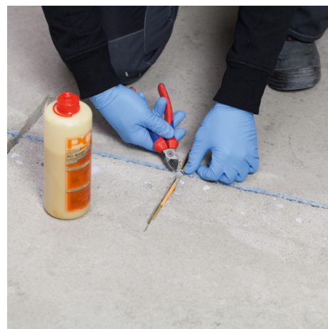
Do drážky vložiť poterové kotvy PCI Apogel® Dúbel alebo poterové spony.
