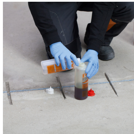
Keď sú škáry alebo drážky pripravené, zmiešať obe zložky PCI Apogel® SH.
