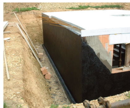
Hydroizolácia vonkajšej steny betónovej pivnice s PCI Pecimor 2K. Jednoduché spracovanie vďaka polystyrénovému plniviu.
