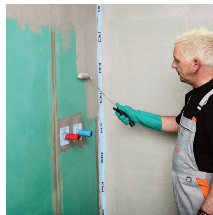
Potom nasleduje celoplošná hydroizolácia.
