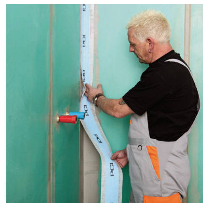
PCI Pecitape sa vkladá do čerstvej prvej vrstvy hydroizolačného materiálu
