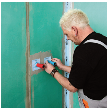
... podobne tesniace manžety opatrne prevlečiť cez stavebnú zátku na rúrku a usadiť do čerstvej hydroizolácie.
