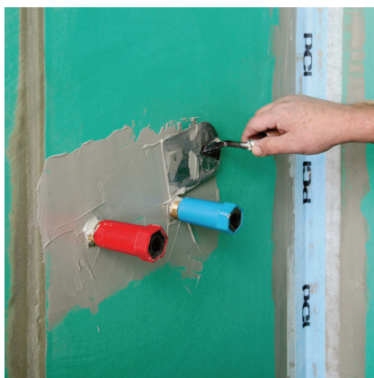
Aj pri utesnení vodovodných rúrok s tesniacou manžetou PCI Pecitape 10 x10 je potrebné najskôr naniesť dostatočné množstvo hydroizolačného materiálu
