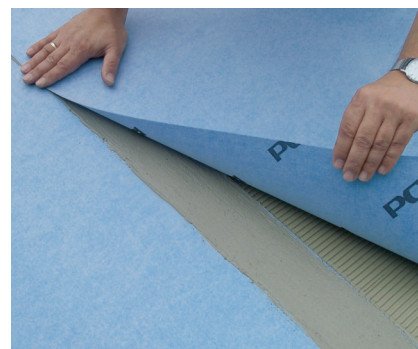
S PCI Pecilastic W môžu byť povrchy citlivé na vlhkosť zaizolované rýchlo a bezpečne.
