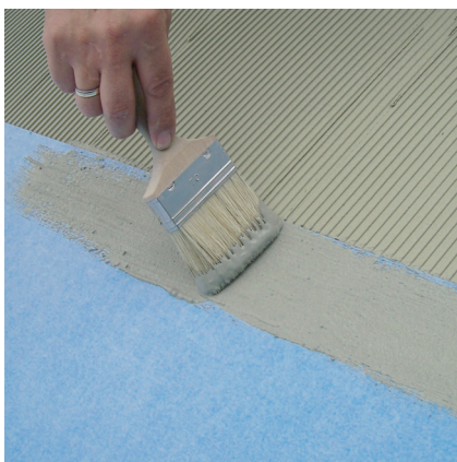
Na dokonalé zlepenie spojov na PCI Pecilastic W je treba použiť PCI Seccoral 1K/2K Rapid.
