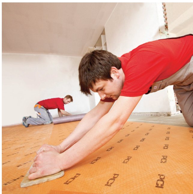
Položiť PCI Pecilastic U a pevne pritlačiť, napr. drevenou latou alebo hladidlom z tvrdenej peny.
