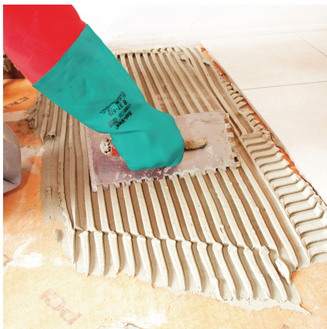
... a do PCI Nanoflott light alebo PCI Rapidflott položiť novú keramickú dlažbu.
