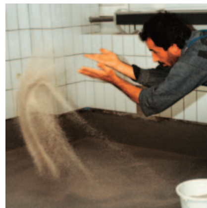
... kremičitý piesok (0,3 až 0,8 mm) vsypať do čerstvej vrstvy PCI Apoflex® F.
