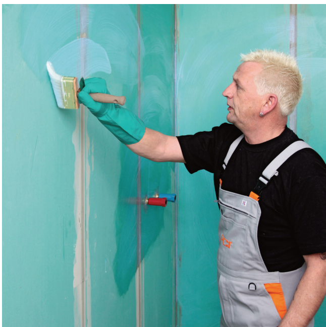
1. Penetrácia: Savé minerálne alebo sadrové podklady a sadrokartónové dosky penetovať s PCI Gisogrund®.
