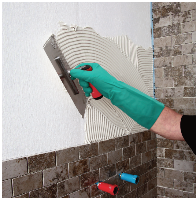
6. Po vytvrdnutí izolačnej vrstvy PCI Lastogum® je možné začať s pokládkou obkladu.
