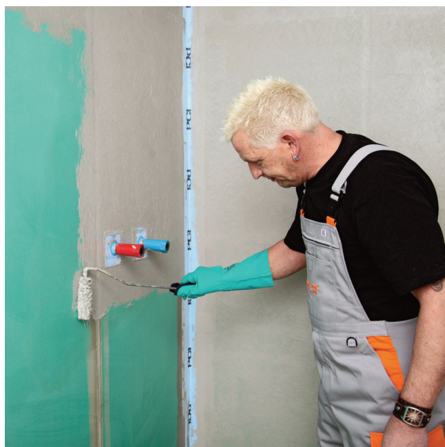
4. Prvú vrstvu PCI Lastogum® (grau) neriedený naniesť celoplošne a sýťo na podklad.
