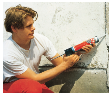
Trhliny v omietke sa dajú plasticko-elasticky vyplniť s PCI Adaptol.
