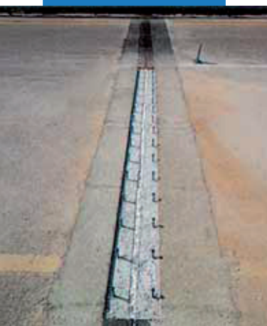
Oprava dilatáčnej škáry diaľničného mostu.
