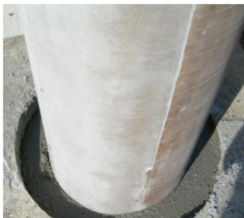
Kotvenie prefabrikovaného stĺpu
