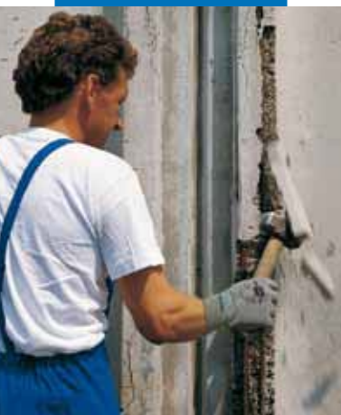
Odstraňovanie degradovaného betónu
