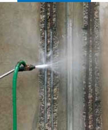
Čistenie výstužnej ocele
