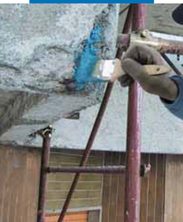
Mapefer 1K aplikovaný štetcom na výstužnú oceľ balkónovej konštrukcie
