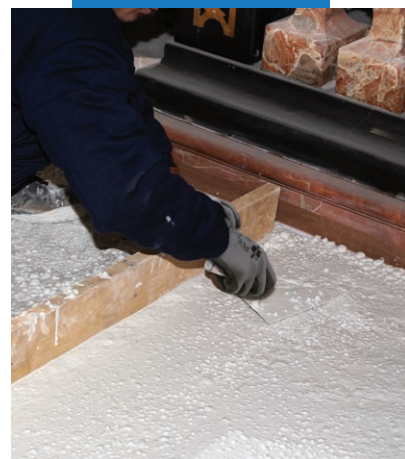
Vyrovnávanie Ultratopu a Dynastone Color ihneď po nanesení
