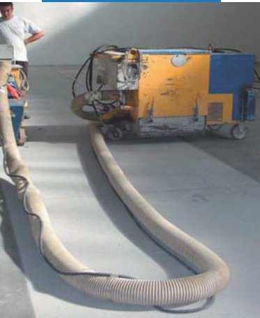
Príprava povrchu otrýskaním
