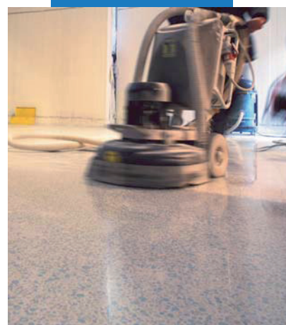
Finálne leštenie podlahy zrealizovanej s Ultratopom a Dynastone Color
