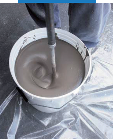
Príprava zmesi ručným miešaním
