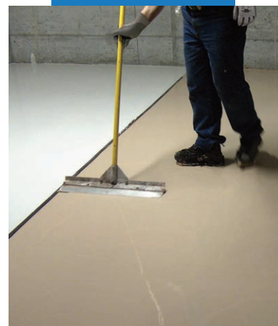
Vyrovňavanie Ultratopu ihneď po nanesení
