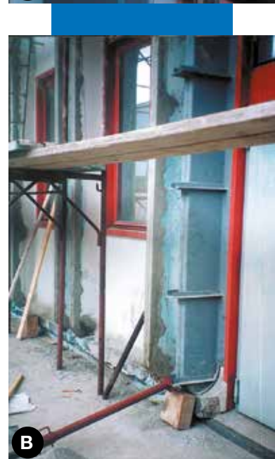
Oprava poškozených prefabrikovaných panelových „žeber“ s použitím betonu vyrobeného ze směsi Stabilcem SCC. A - Před opravou. B - Po opravě.
