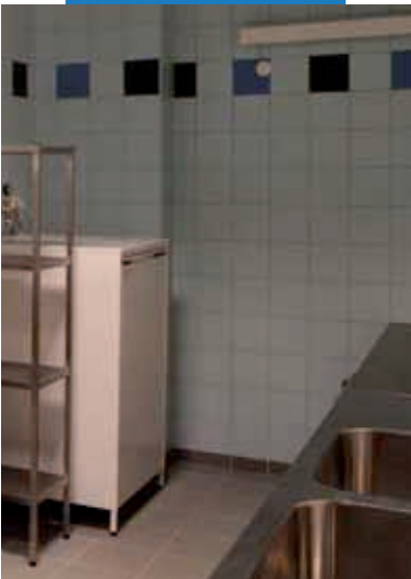
Keramický obklad inštalovaný na podklad ošetrený penetračným náterom Primer S - Nemocnica Olomouc - Česká Republika
