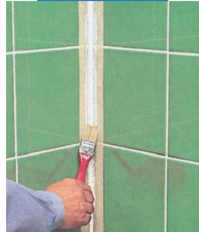
Vyhľadzovanie povrchu škáry saponátovým roztokom a malým štetcom.
