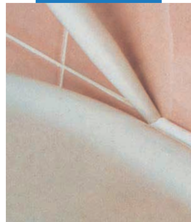
Tesnenie škár v styku so sanitárnym zariadením.
