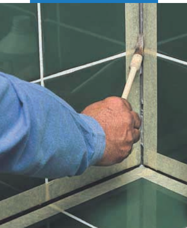
Nanášanie penetračného náteru Primer FD.
