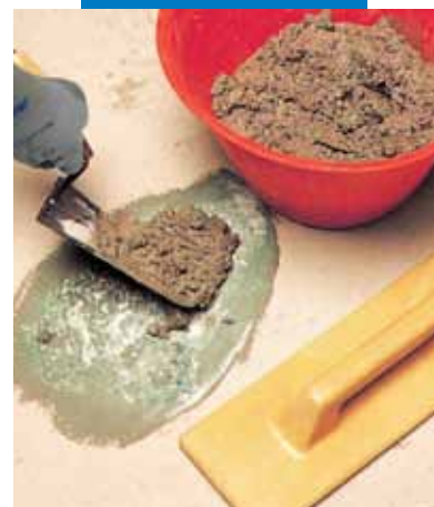
Lokálna oprava podlahy. Aplikácia vyrovnávacej malty
