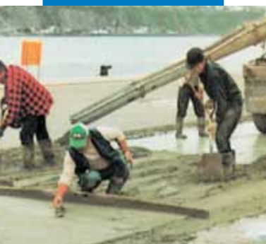
Cementový poter aplikovaný v exteriéri s prísadou Planicrete - Vieux Port - Quebec (Kanada)
