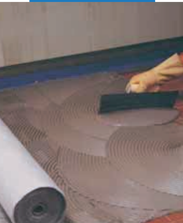
Mapelastic nanášaný v prvej vrstve s následnou inštaláciou tkaniny Mapetex Sel
