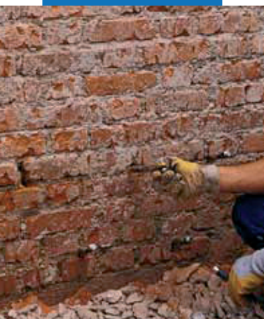
Vloženie injektorov do otvorov
