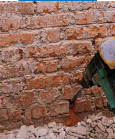
Vŕtanie otvorov v odsadených radoch
