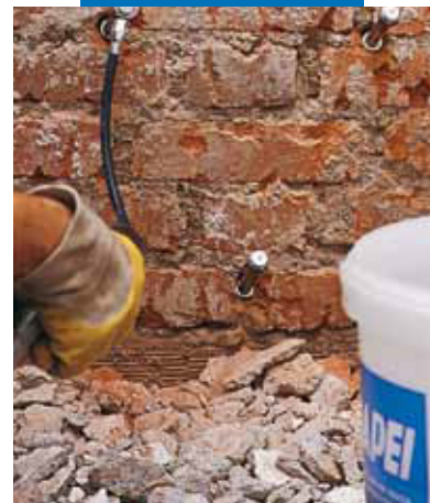
Nízkotlaková injektáž Mapestop
