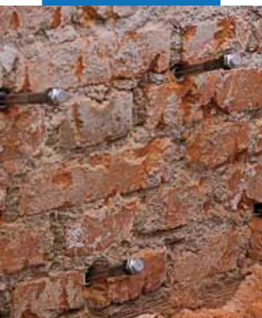
Detail osadených injektorov
