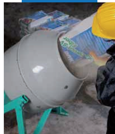
Príprava zmesi Mapegrout SV Fiber
