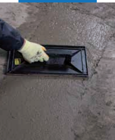
Ošetrovanie povrchu Mapegrout SV Fiber
