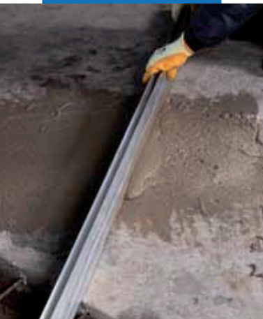
Vyhľadzovanie malty Mapegrout SV Fiber
