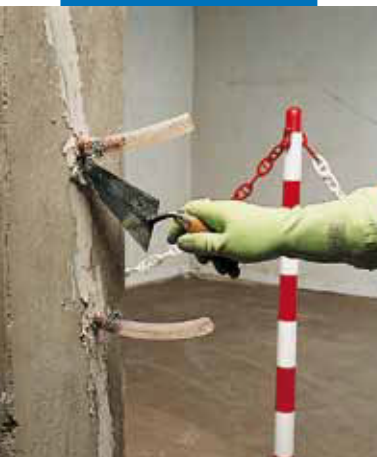
Upevnenie injektážnych trubic pomocou Adesilex PG1
