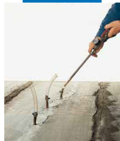
Oprava horizontálnej štruktúry injektovaním výrobku Epojet
