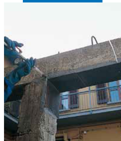
Oprava nosníka injektovaním výrobku Epojet
