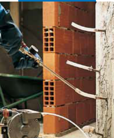
Epojet injektovaný do popraskaného piliera
