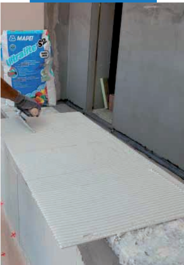
Nanosenie lepidla na zadnú stranu obkladového prvku
