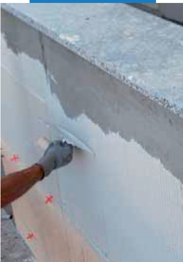
Inštalácia na vonkajšej fasáde: nanosenie lepidla na podklad
