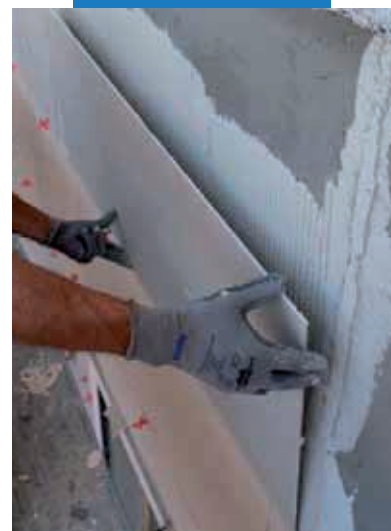
Inštalácia porcelánového obkladového prvku tenkej hrúbky na vonkajšej fasáde
