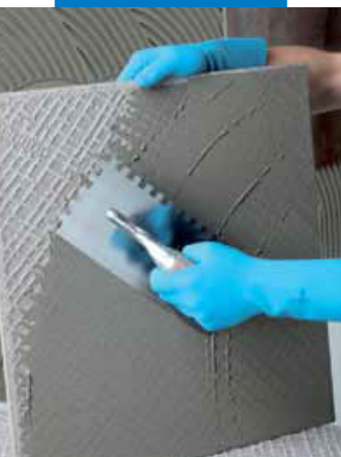
Nanesenie lepidla na zadnú stranu obkladového prvku
