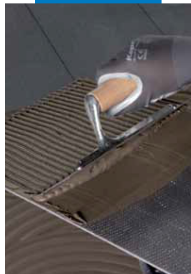
Nanesenie lepidla na zadnú stranu obkladového prvku
