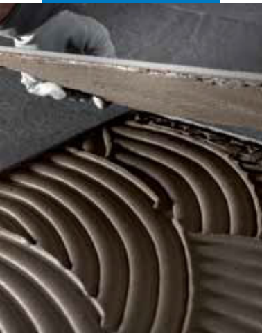
Inštalácia tenkej porcelánovej dlažby
