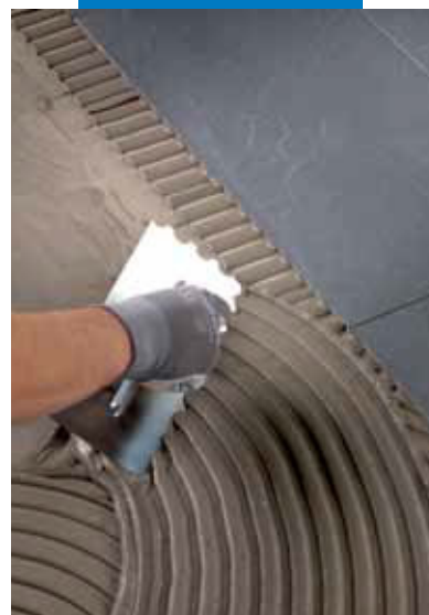
Nanesenie lepidla štírkou s oblúkovým zubom
