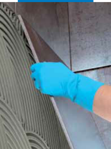
Inštalácia velkoformátového obkladového prvku na stenu
