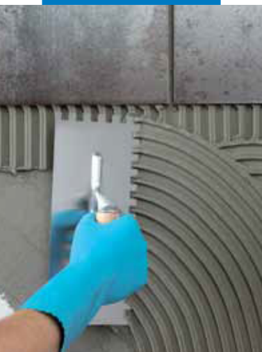
Nanesenie lepidla zubovou stierkou na stenu
