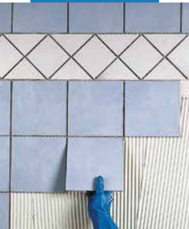
Inštalácia jeden krát vypaľovaných obkladových prvkov na sadrokartónovej doske
