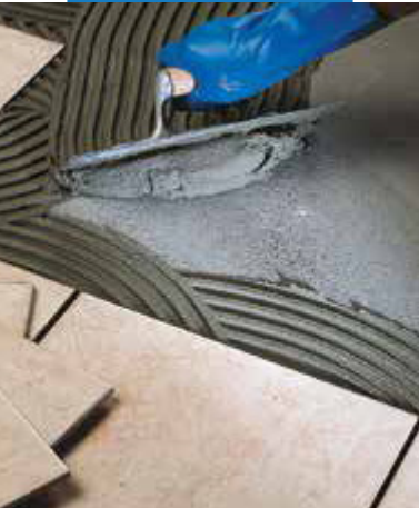
Inštalácia jeden krát vypaľovaných obkladových prvkov
